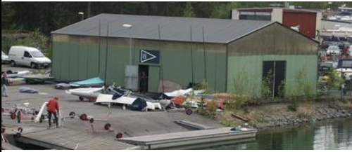
Stora förrådshallen initierades och byggdes 1990 av jolleföräldrar. Invest. ca 25.000 kr.
