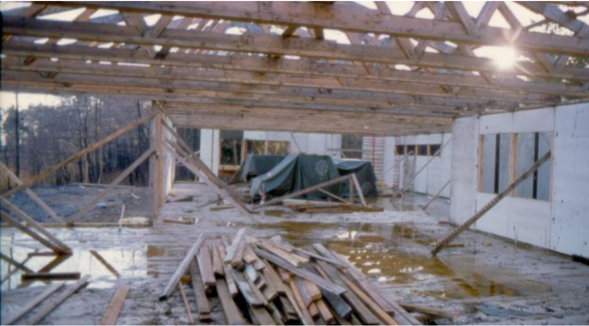
Stomme och delar av väggar resta
